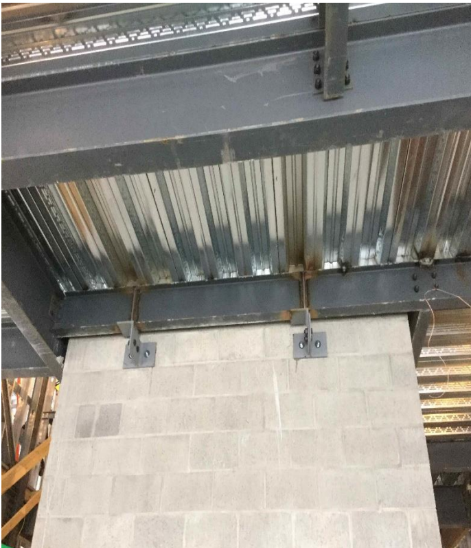
Seismic Clips
